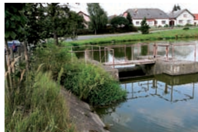
Obr. 14: Sdužený bezpečnostní objekt
