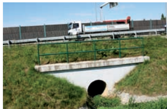
Obr. 6: Kombinace neprůchodného propustku a protihlukové stěny
