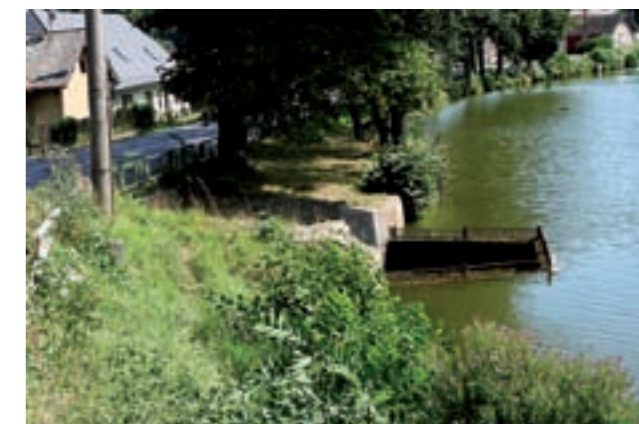
Obr. 15: Kašnový bezpečnostní přeliv
