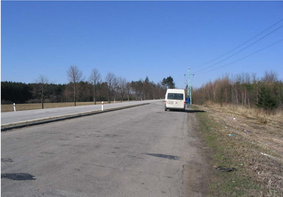
Foto: Stanoviště č. 02 Řehořov, kontrolní a vážící místo
