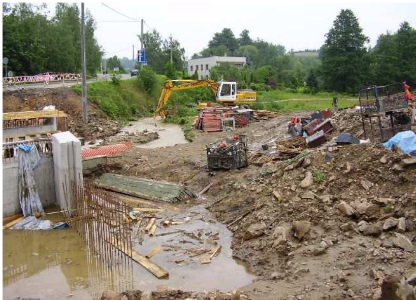
místní část Mostiště, oprava mostu, 3.7.2009
