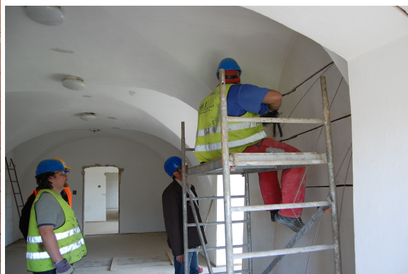
Statická sanace helikální výztuží
