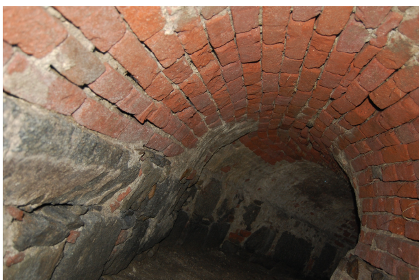
Sanace podzemní chodby
