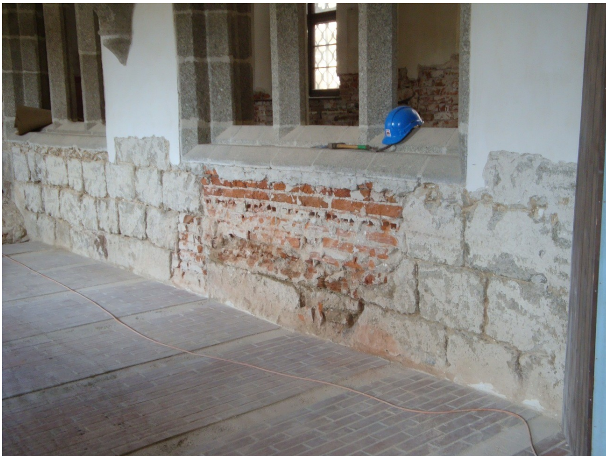
Jižní křídlo ambitu ze 13. století – zdivo, které se nedochovalo, bylo doplněno v roce 1969
