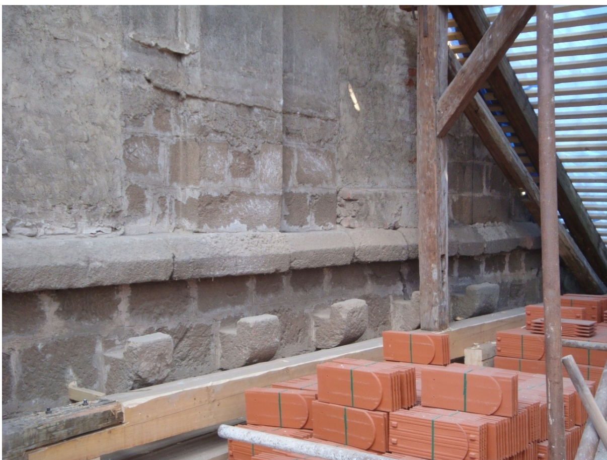
Po odstranění krytiny ze střechy je osvětlena stěna baziliky, na které je tak výborně viditelný dochovaný závěsný systém dávného krovu.
