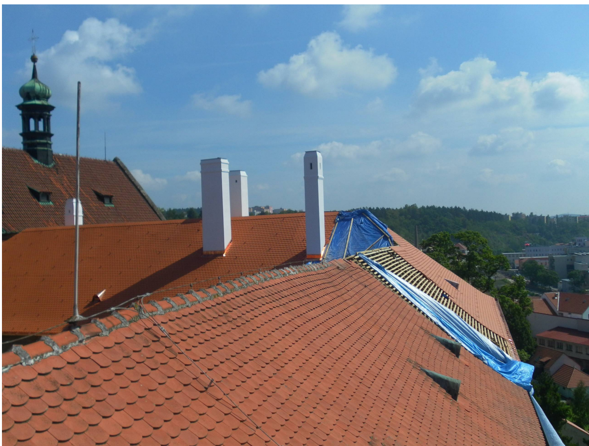
Opravené komíny a pokračování pokrývačských prací - demontáž střešních tašek
