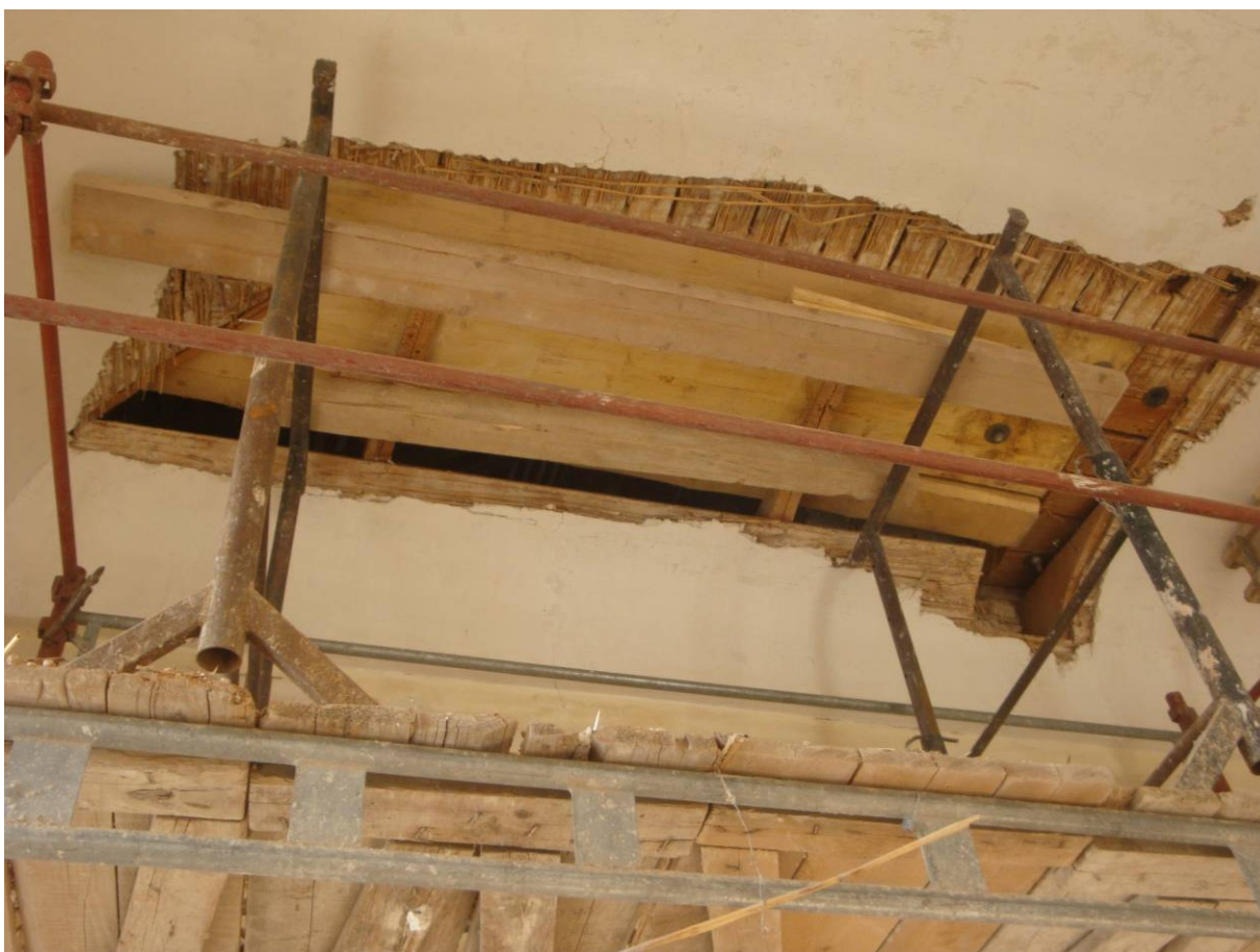
Degradované části stropů byly vyměňovány. Nové hranoly jsou ukotveny k ocelové konstrukci v půdním prostoru.
