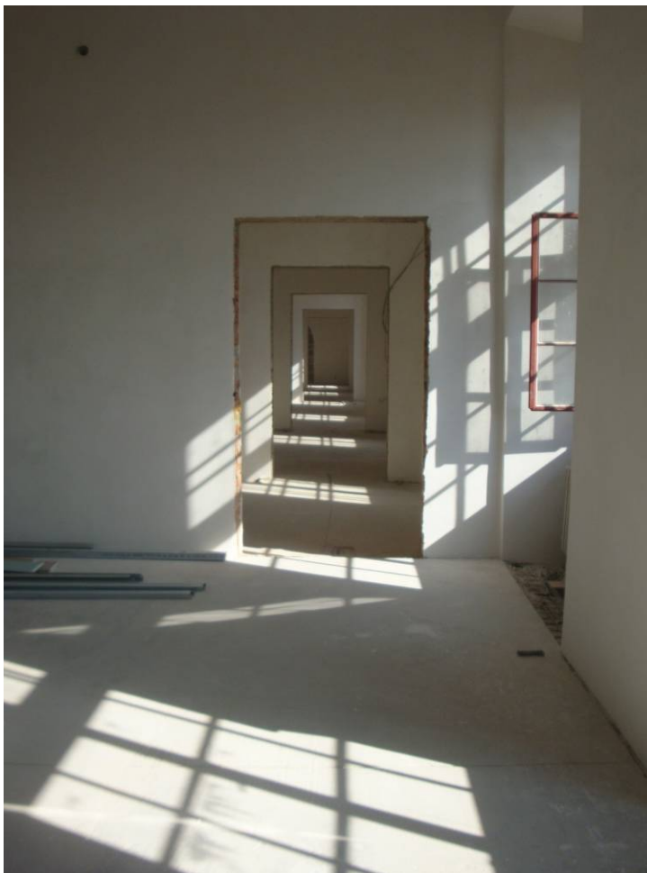
Obnovením enfilády ve východním křídle vznikl prostor, který působí vznešeně a přívětivě. Na stěnách místností je gletovaná omítka.
