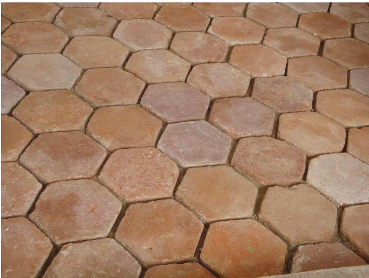
Obr. 4 – Rekonstruovaná původní dlažba
