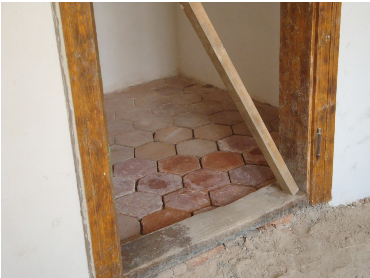
Obr. 3 – Rekonstrukce původní dlažby
