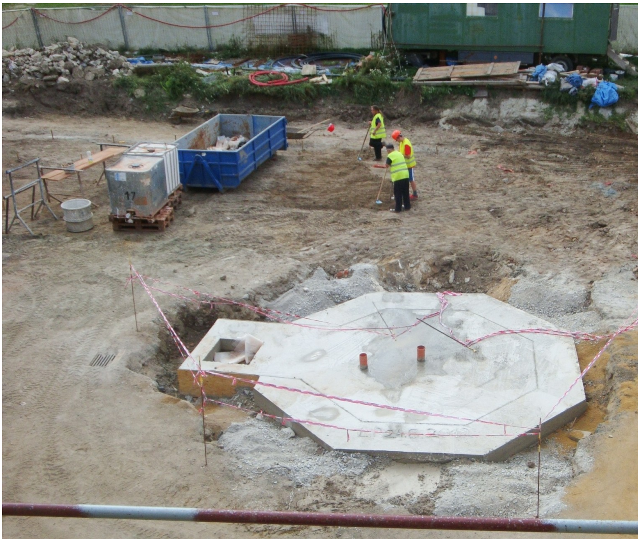
Vybetonovaná podkladní deska pod kašnu.
