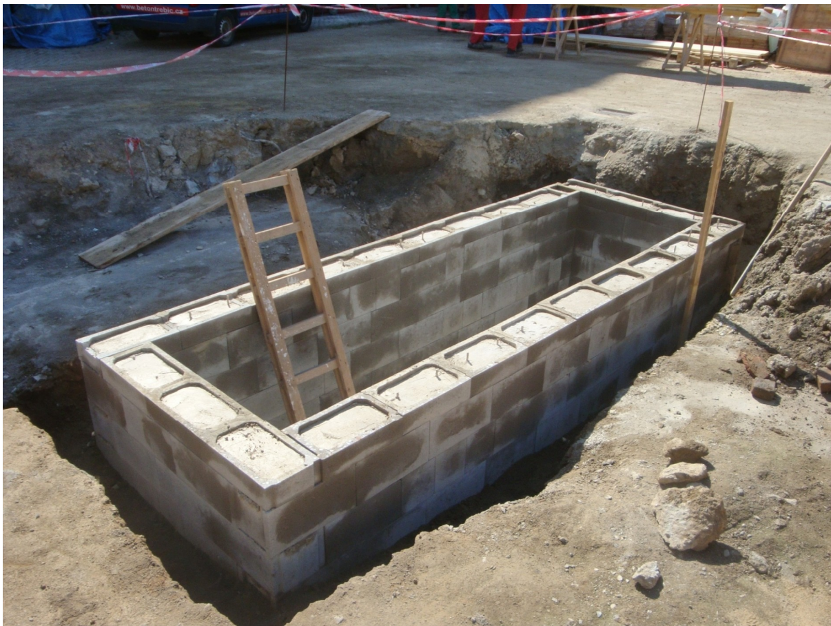
Betonáž šachty pro technologii kašny.
