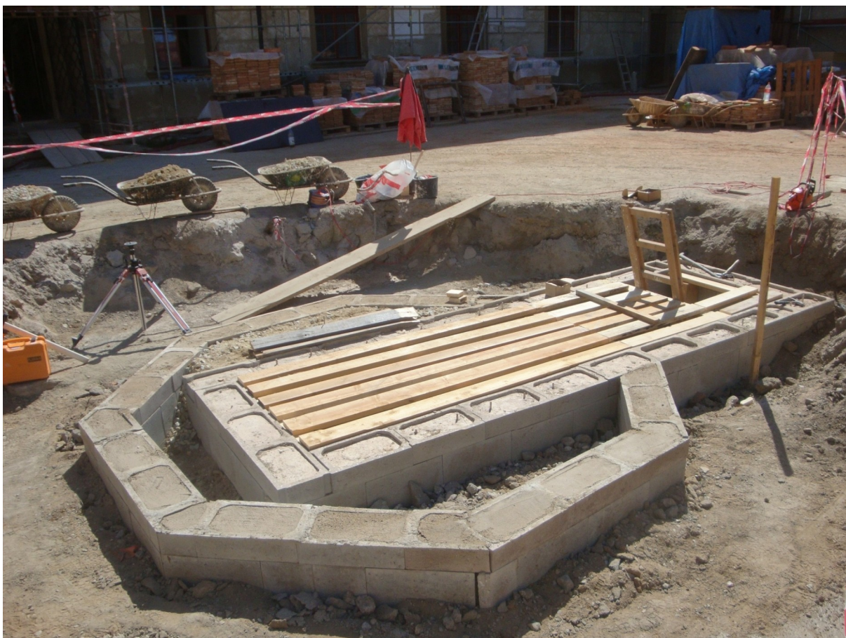
Betonové základy pro vlastní kašnu.
