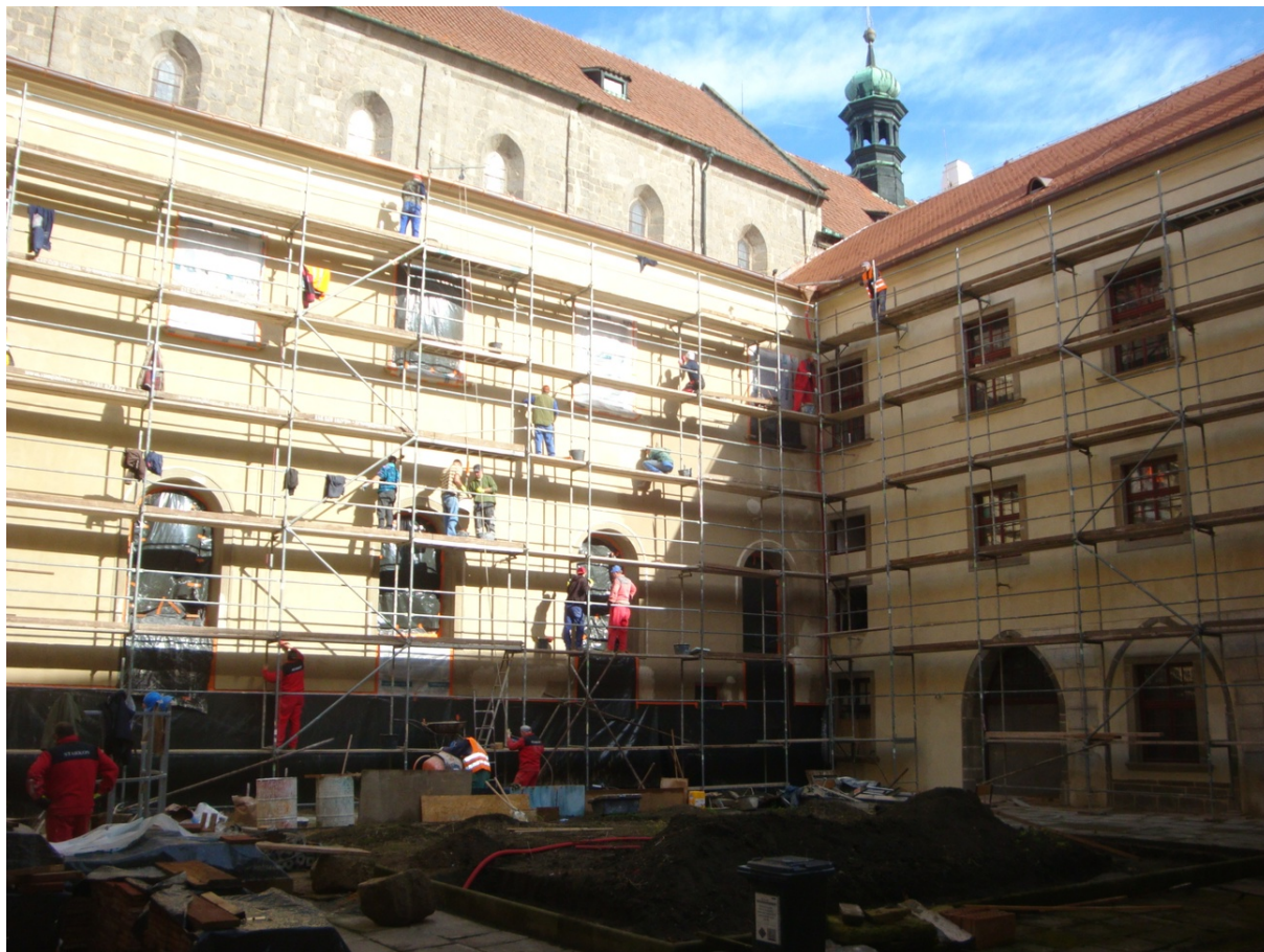
Obr. 5 – Práce na fasádě Rajského dvora
