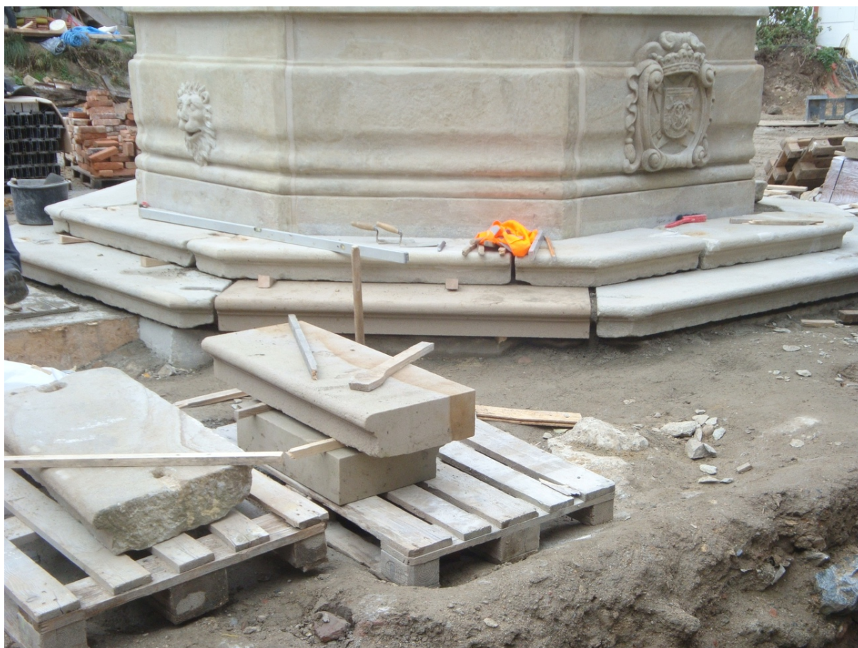
Obr. 1 – Osazování zrestaurovaného schodiště okolo kašny.
