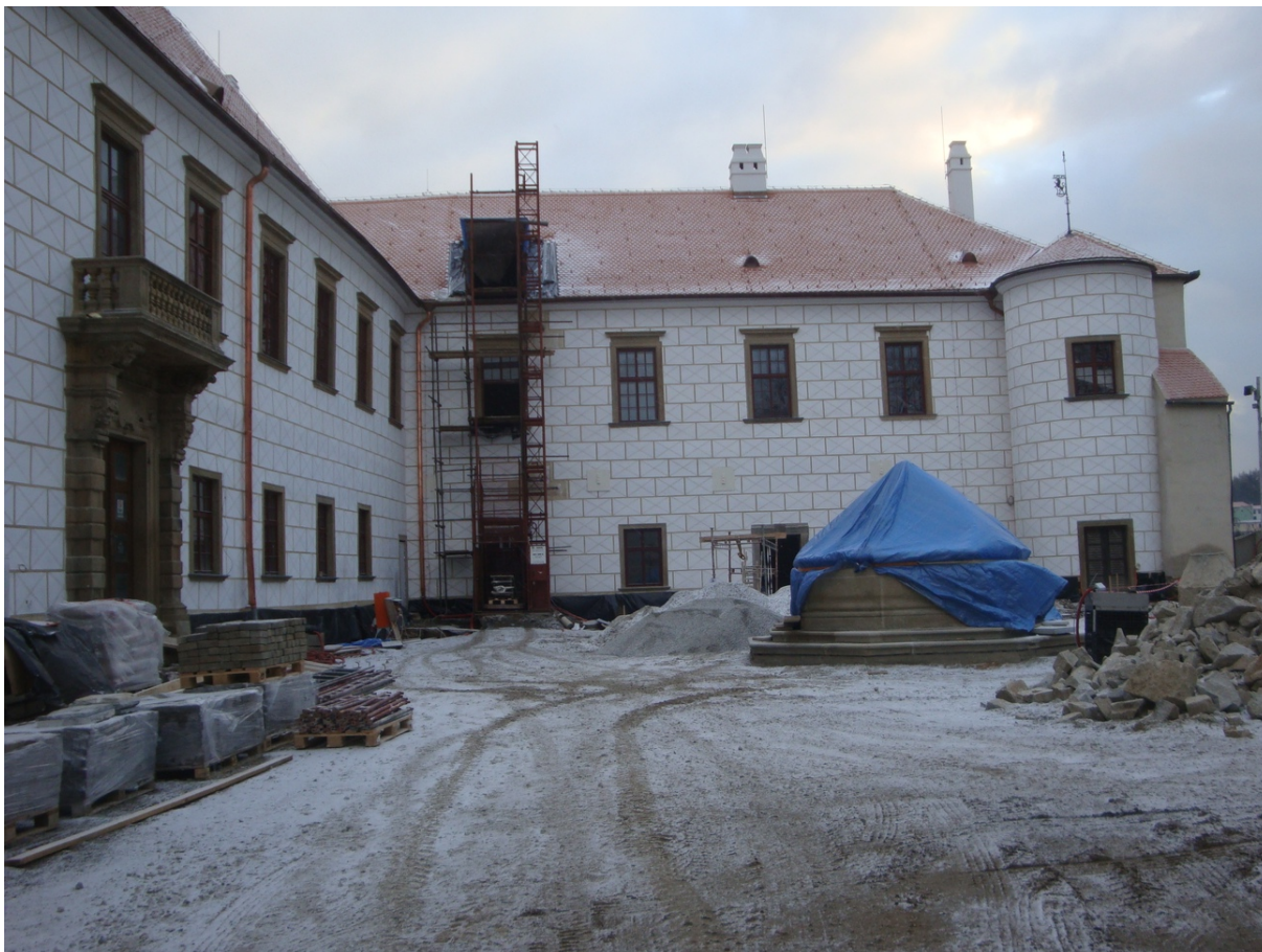
Obr. 2 – Pohled na nově opravenou fasádu hlavního nádvoří.
