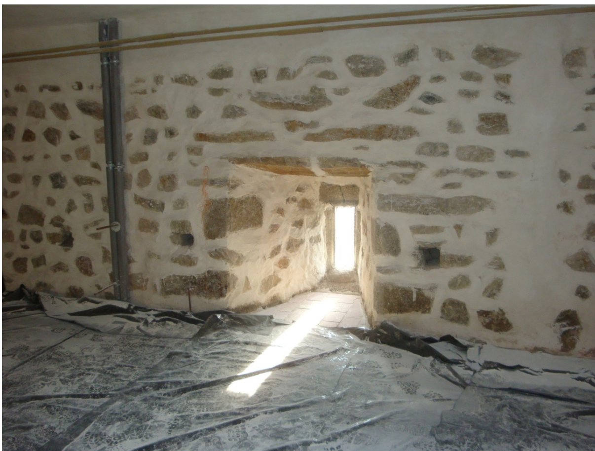
Obr. 5 – Místnost č. 0.16 již s hotovou podlahou, překryta ochrannou folií.
