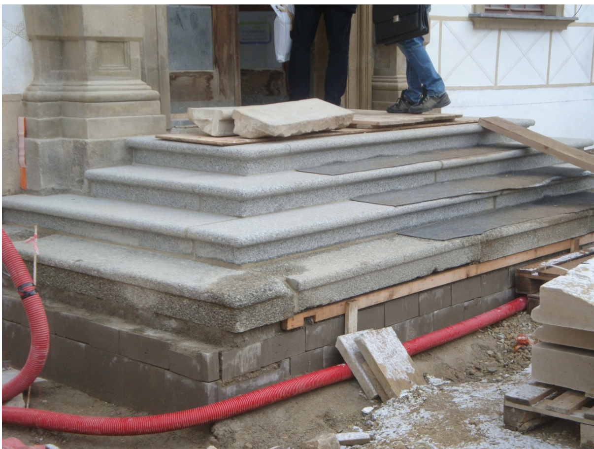
Obr. 3: Vstupní schodiště před hlavním vchodem.
