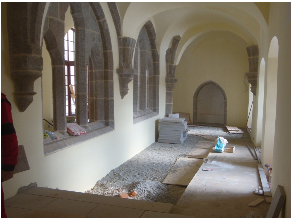
Obr. 7: Pokládka kamenné dlažby v prostorech budoucí klášterní expozice.
