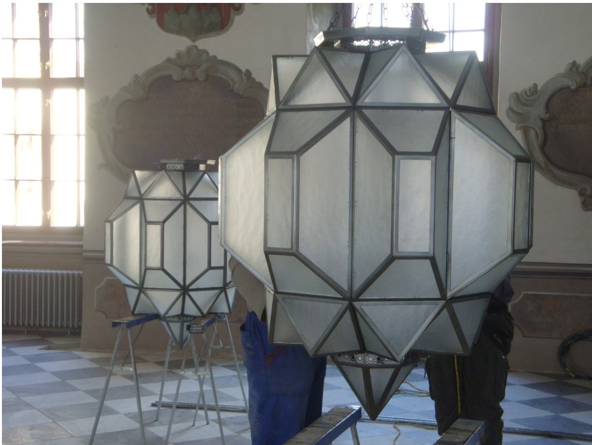
Obr. 6: Osazování historizujících svítidel v Kamenném sále.
