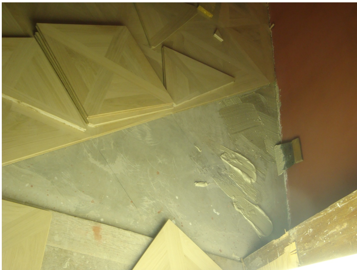
Obr. 1: Pokládka podlahy v místnosti 2.03.
