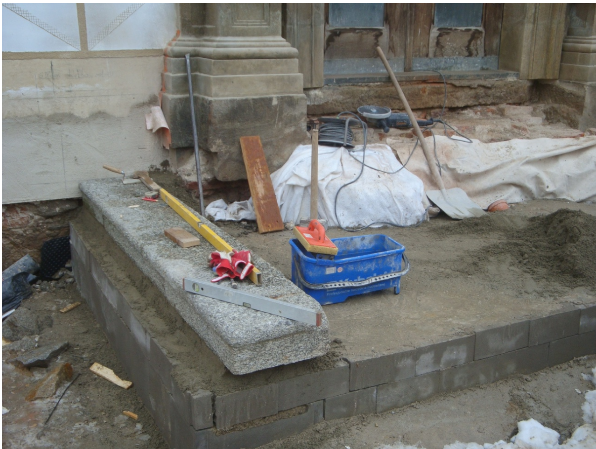
Obr. 2: Osazování schodiště u hlavního vchodu.
