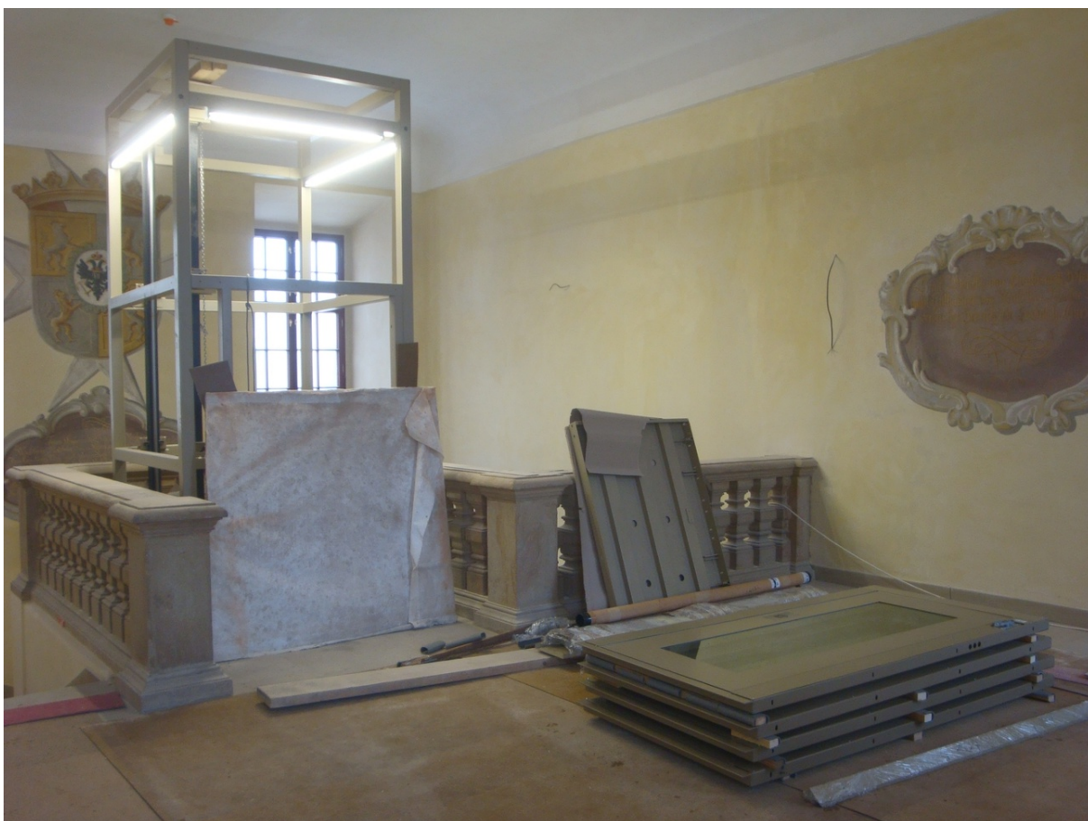
Obr. 5: Montáž výtahu v místnosti 2.01.
