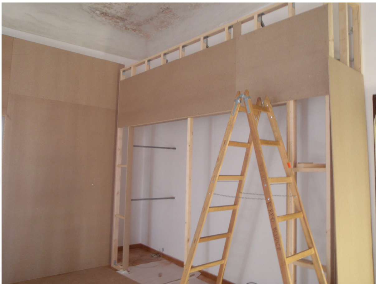
Obr. 4 – Montáž vestaveb v místnosti č. 2.18
