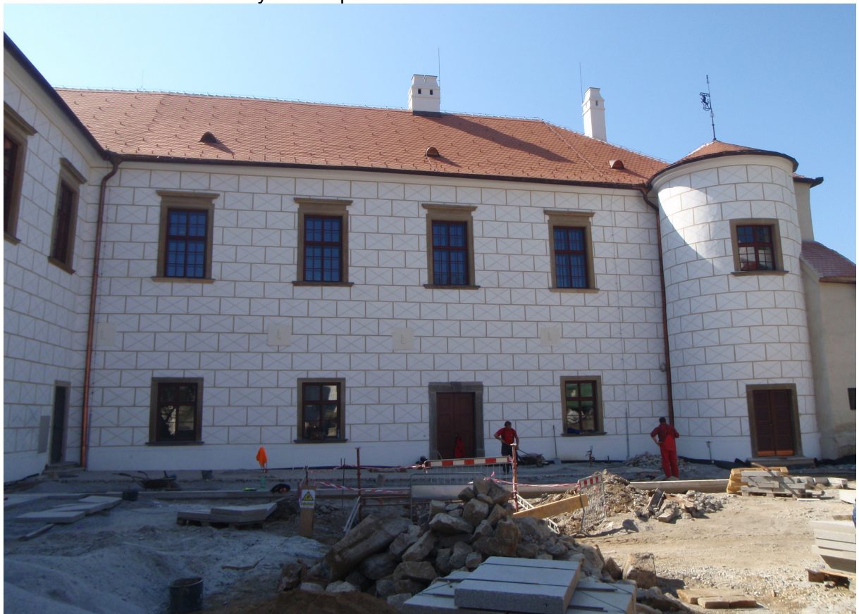
Obr. 2 – Opravená fasáda křídla Osovských, probíhající práce na vstupním nádvoří.
