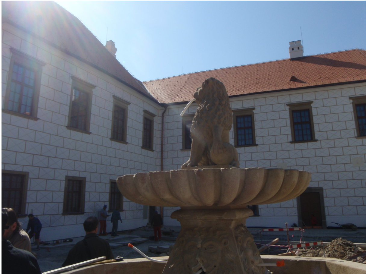
Obr. 1 – Restaurování kašny na vstupním nádvoří.
