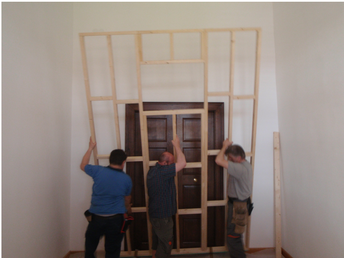
Obr. 5 – Montáž vestaveb v místnosti č. 2.27
