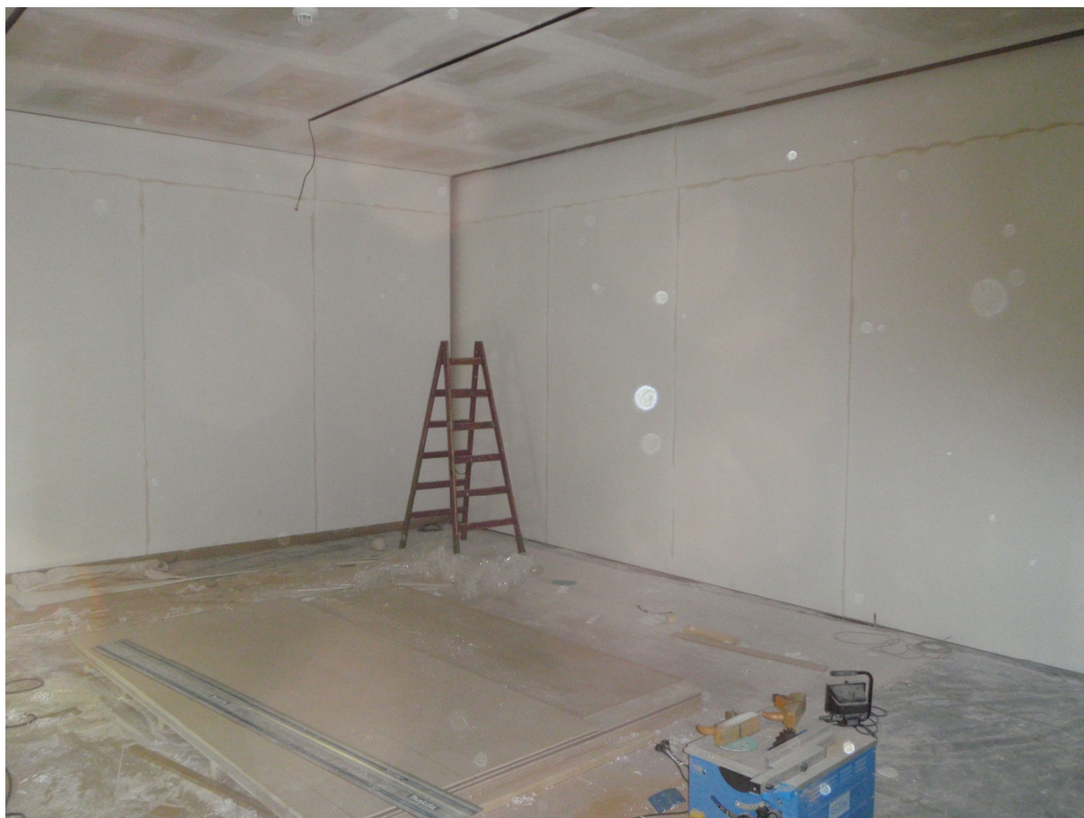
Obr. 1 – místnost č. 2.19 – budoucí expozice Člověk bojující
