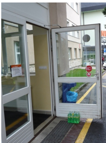
Obrázek 37. Veškeré zabezpečení zhatí např. dodavatel
