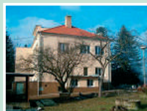
Obrázek 60: Hlavní budova pracoviště ve Studenci
