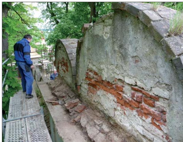
Oprava ohradní zdi zámku v Brtnici v rámci modulu Zedník
