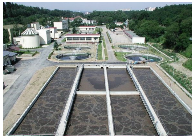
mechanicko-biologická ČOV Třebíč
