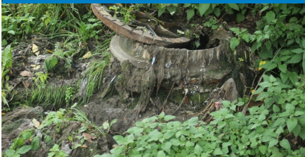
Jihlava – šachta před odlehčením, pod mostem ul. Havlíčkova
