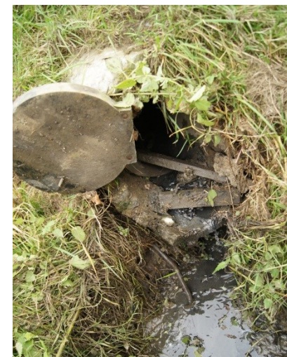
Jihlávka – pod křížením s ul. Brtnickou
