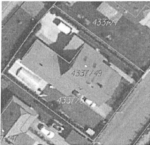
Obrázek 1: Stav před revizí
