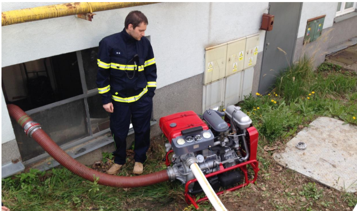
Technický zásah z čerpání zaplavené kotelny
