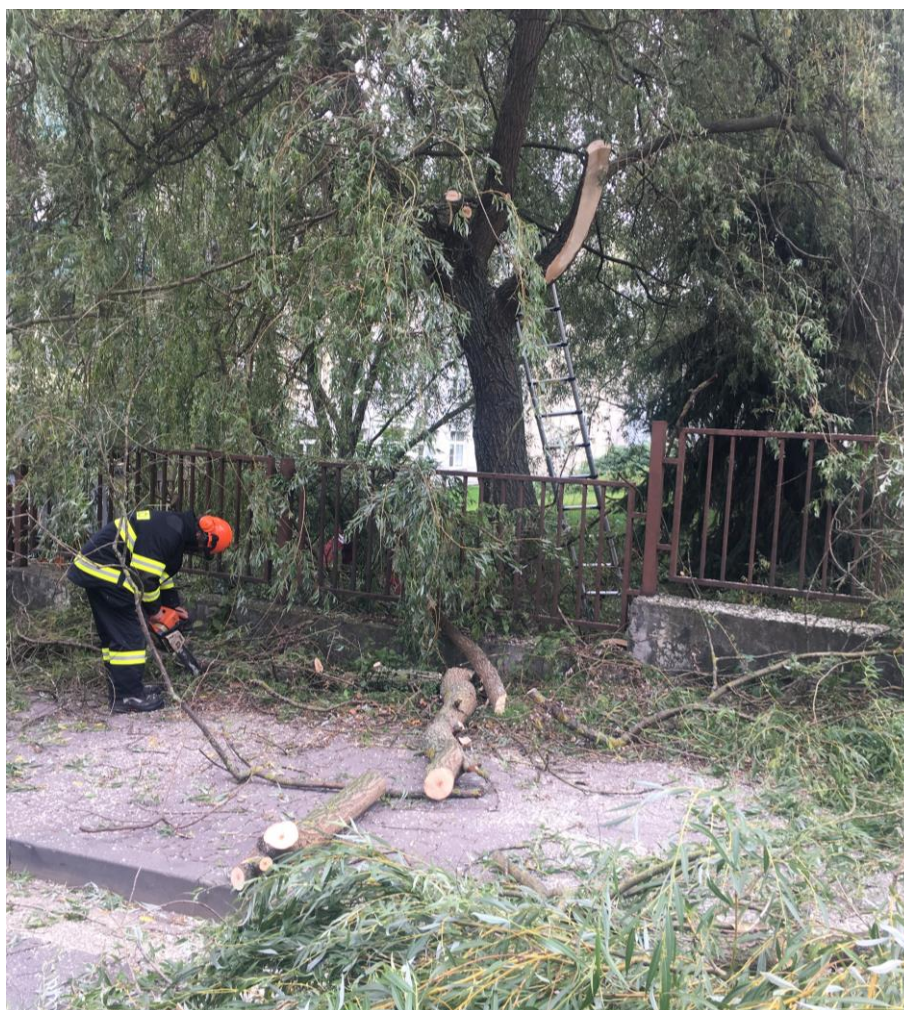
Odstraňování nebezpečných dřevin v areálu nemocnice
