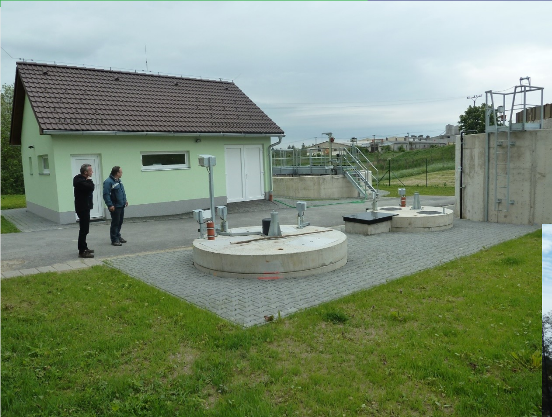
ČOV Dolní Heřmanice (2014)
