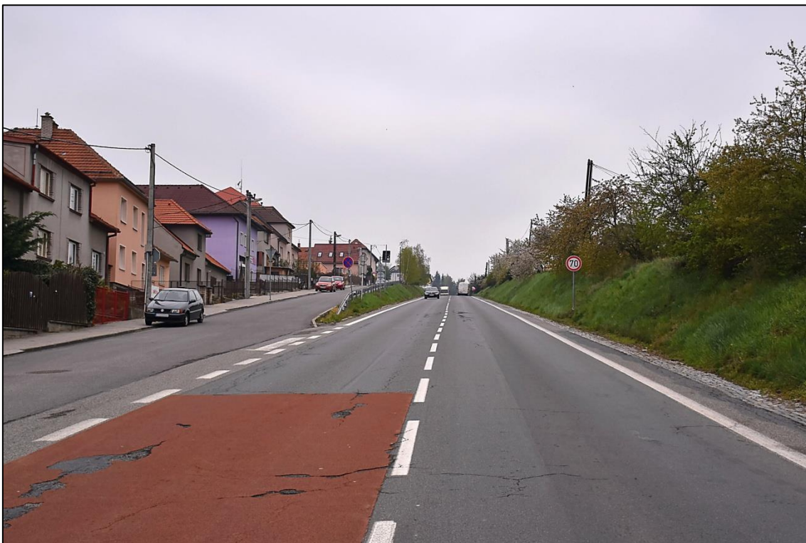
Obrázek 85: Pohled na ulici Jihlavská od ulice K Novému světu (zřejmá značka povolující v tomto úseku obce vyšší rychlost).
