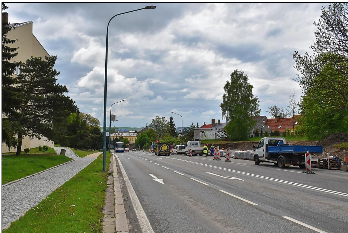
Obrázek 73: Pohled na ulici Hradební od Hradebního příkopu poblíž Brány Matky Boží.
