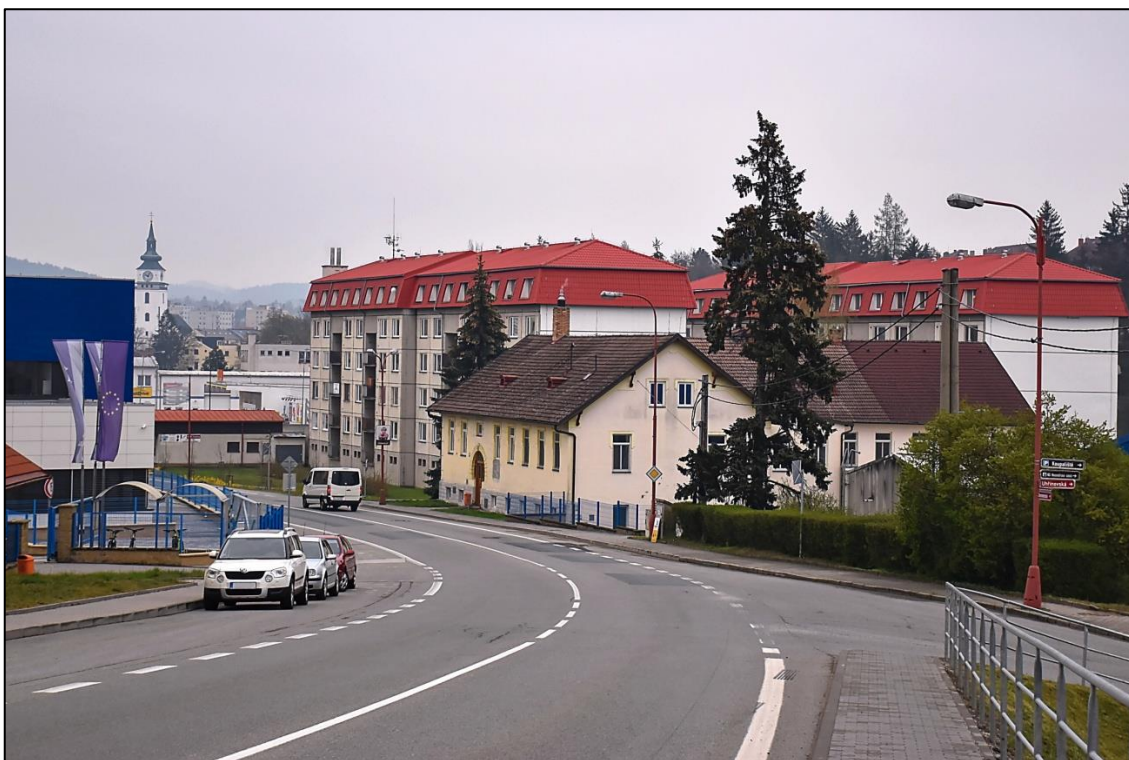
Obrázek 70: Pohled na ulici Hornoměstská poblíž křižovatky s ulicí Uhřínovská (zasažené vysoké obytné budovy s červenými střechami).
