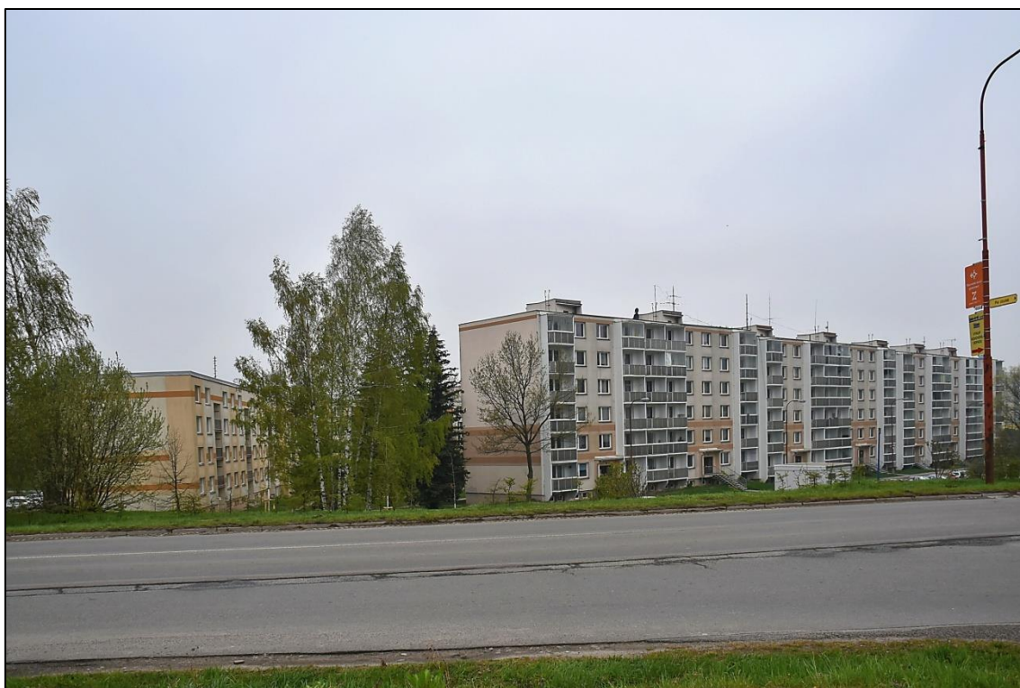
Obrázek 36: Pohled na zasažené panelové domy na ulici Haškova od garáží na ulici Jihlavská.
