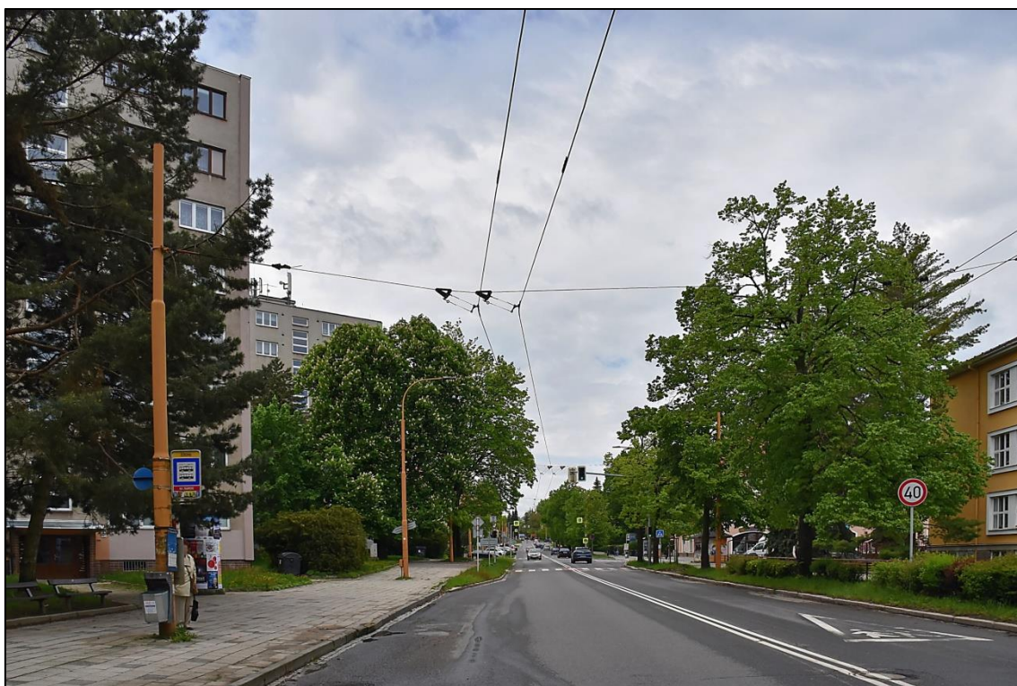
Obrázek 51: Pohled na ulici Žižkova směrem na Pelhřimov (vlevo vysoké panelové budovy, vpravo značka omezující rychlost v obci).
