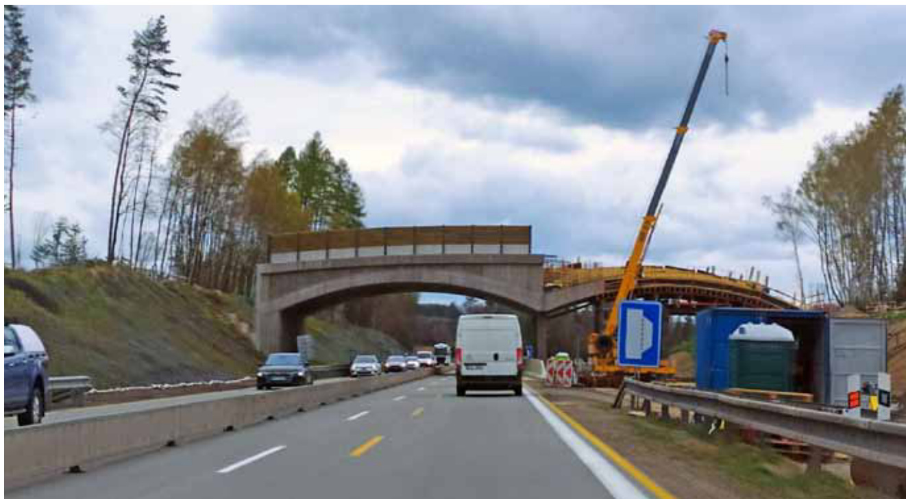
Obr. 9: Zelený most budovaný na migračním koridoru na dálnici D1 v úseku mezi Jihlavou a Měřínem. Dálnice D1 je v úseku přes Českomoravskou vysočinu zcela neprůchodná pro velké savce. Čtyři nové ekodukty by měly tuto situaci výrazně zlepšit.
